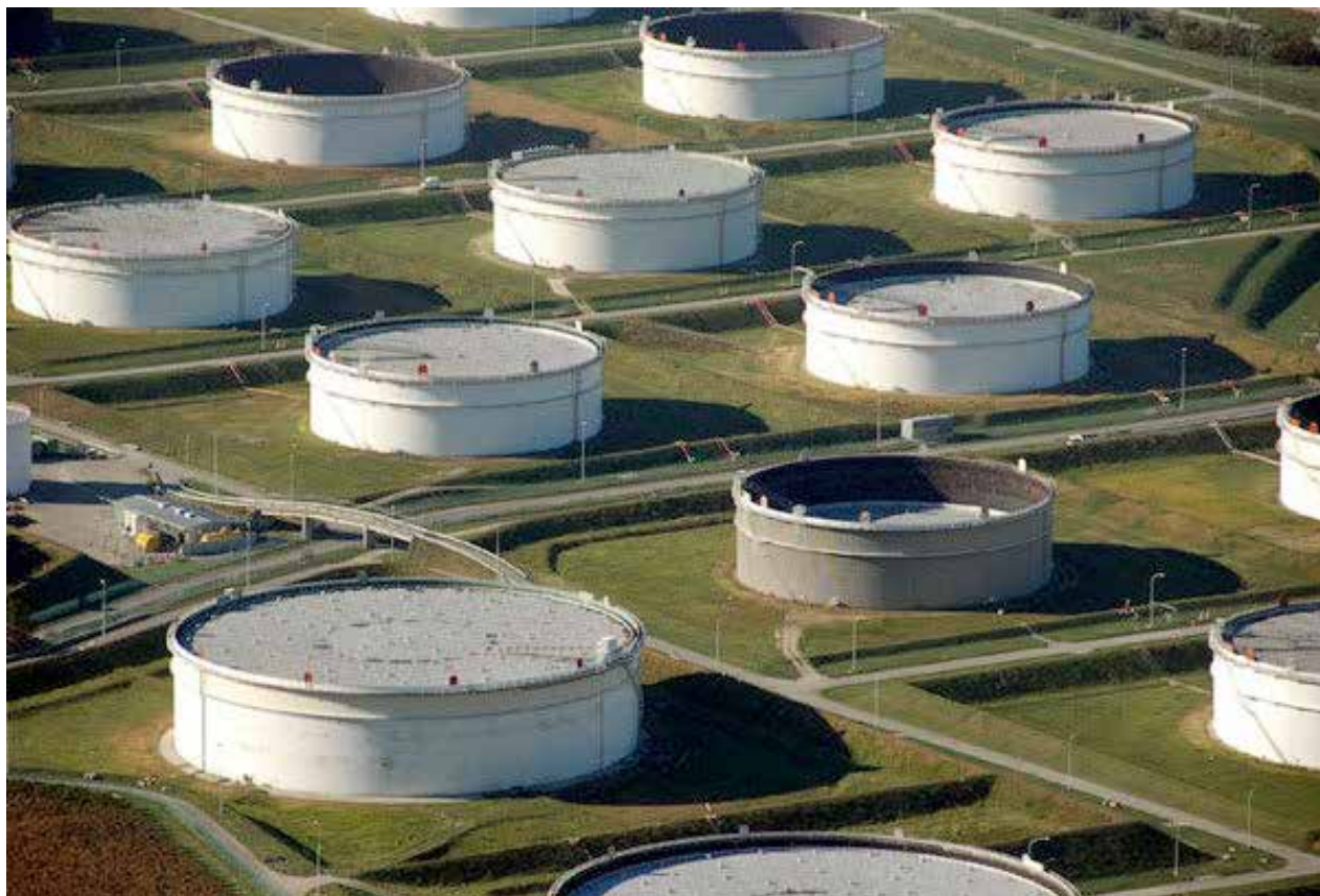
Slika 5: Izgradnja novog rezervoarskog prostora JANAF d.o.o.
