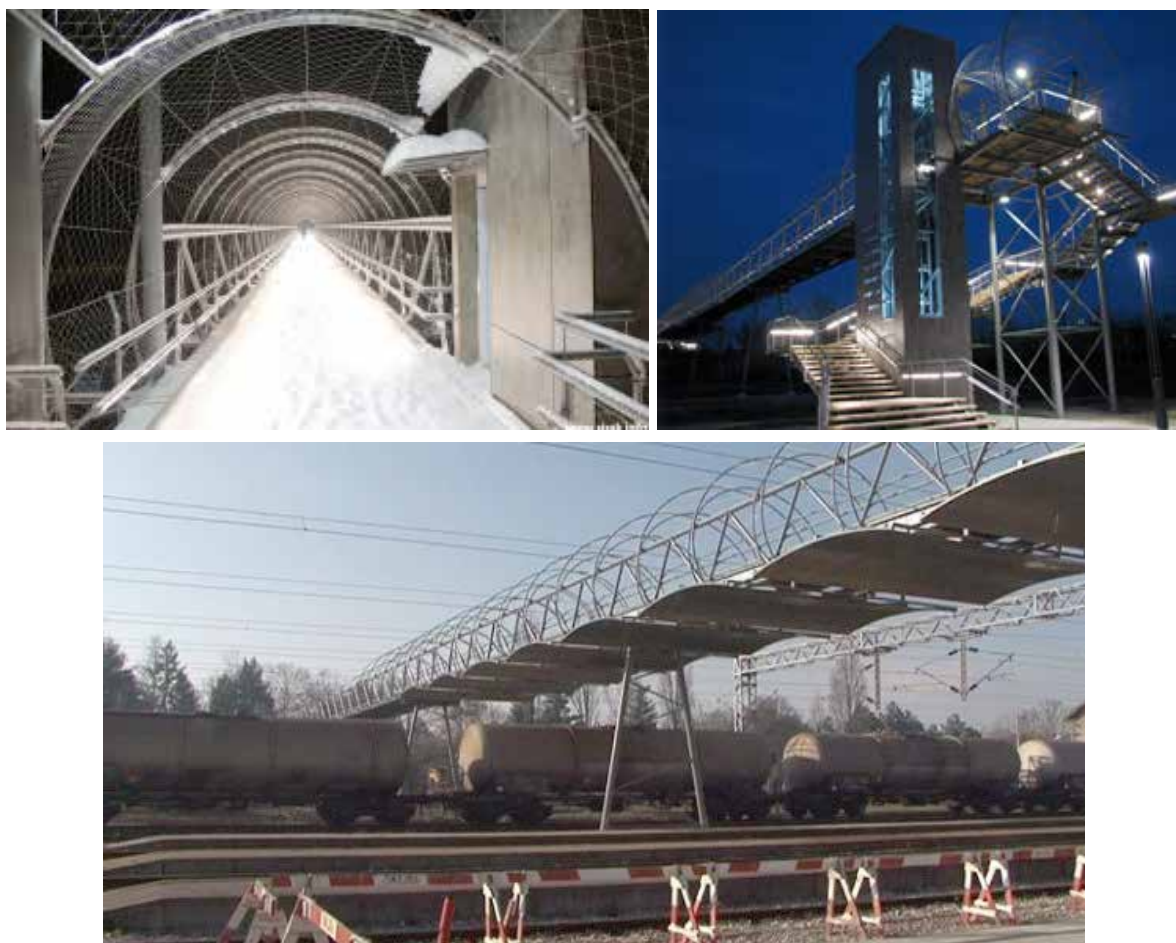
Slika 9: Pasarela na željezničkom kolodvoru Caprag u Sisku
