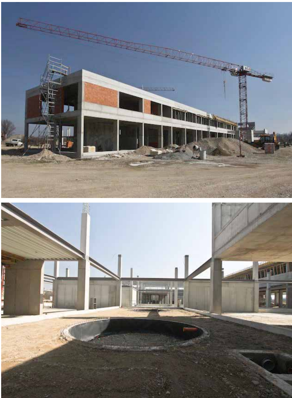
Slika 15: Gradnja nove obrtničke škole u Sisku
